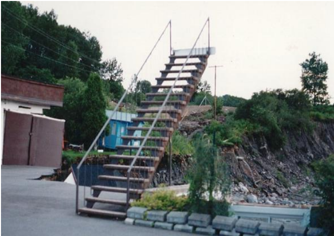
L'escalier qui menait au deuxième étage.
